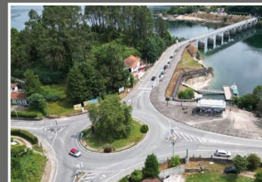
REQUALIFICAÇÃO DE PAREDES - RIO CALDO
